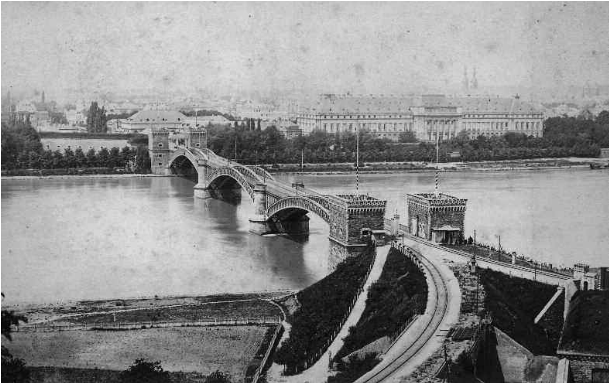
Die Pfaffendorfer Brücke war zunächst eine reine Eisenbahnbrücke, wie auch auf diesem sehr frühen Foto zu erkennen.
